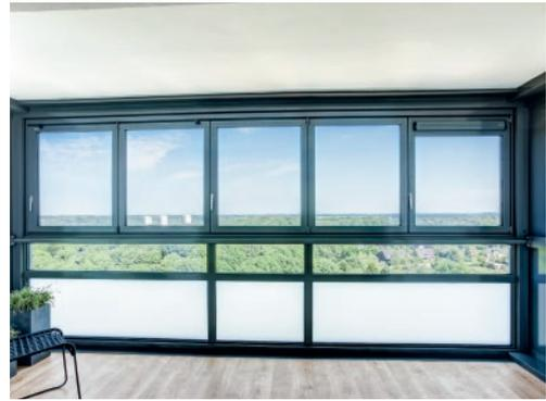
Im Lüftungskonzept mit berücksichtigt: Jede der 56 Glas-Faltwände ist mit einem 80 Zentimeter breiten Lüfter ausgestattet. Die Größe der Balkone konnte durch die auf die Außenseite der Fassade verlagerte Wärmedämmebene komplett erhalten bleiben.
